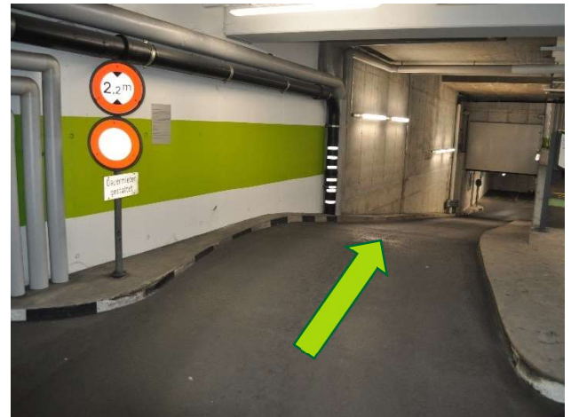
Rampe ins 1.Untergeschoss
