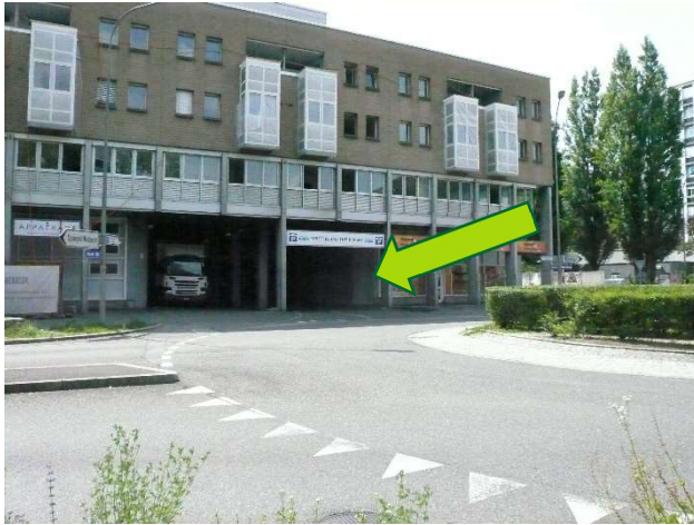
Einfahrt Parkhaus «Steinhölzli-Märit»
