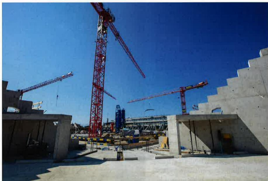
La moitié du gros œuvre est réalisée. On aperçoit sur les photos les gradins et les voiles verticaux des tribunes.
